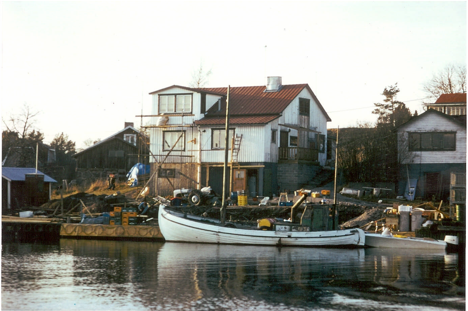
Fotot från N. Stavsudda Oktober 1973. Bygget av den nya butiken påbörjat, i förgrunden Göran Ivanoff´s gamla skuta "Anne-Marie" Affären låg fram till nu i det vita huset -där byggställningen är.
